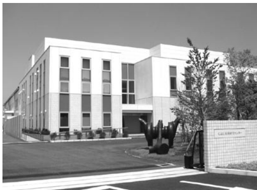
写真-1 G&U技術研究センター全景
